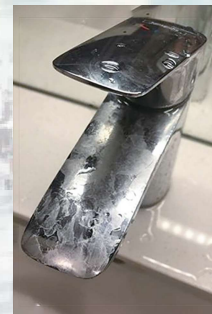
洗面台蛇口施行前
