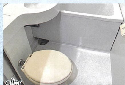
3点ユニットバス 施工例
